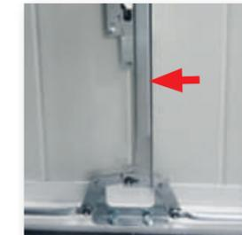
Pour toutes les portes motorisées, un verrouillage mécanique au sol activé par le moteur complète ce dispositif.
